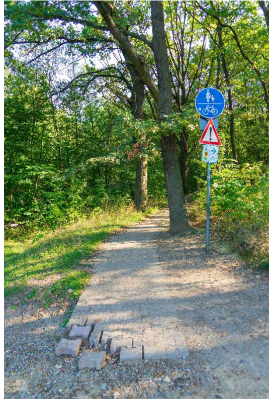
Zustand Spreeradweg im Bereich Gesundbrunnen / Anbindung Talsperre
